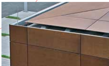
Административное здание в Гиншайм-Густавсбурге, Германия. Обладатель награды Deutsche Fassadenpreis 2011. Проект компании Hille Architekten, фотограф Хорст Гебель.
